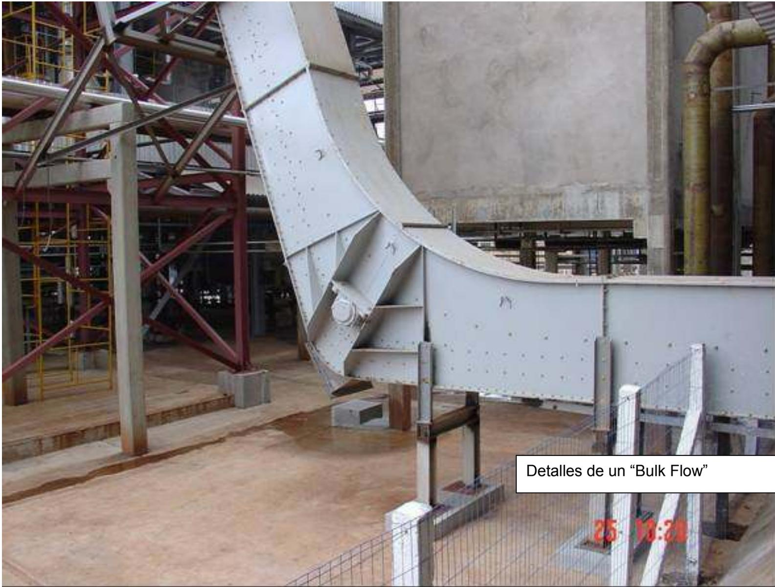
Detalles de un "Bulk Flow"
